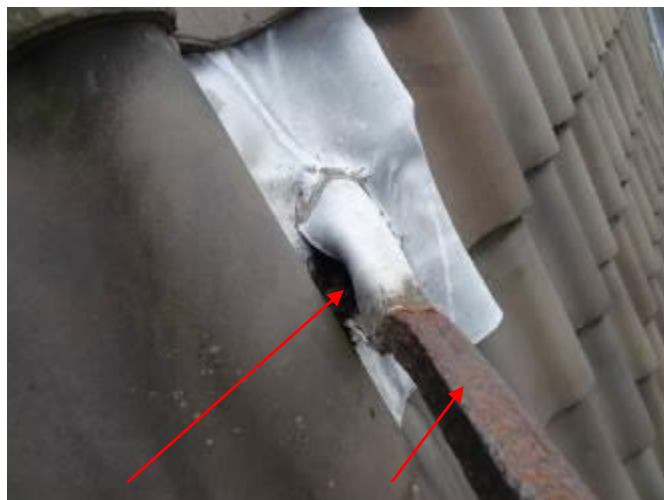
foto 1 manchets herstellen en ijzerwerk behandelen
